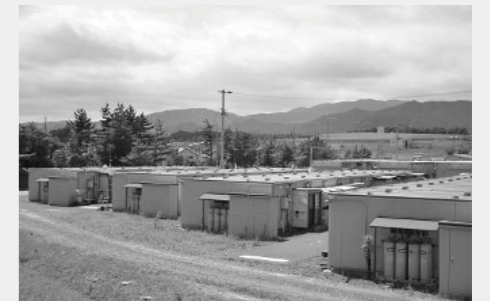
建ち並ぶ仮設住宅
