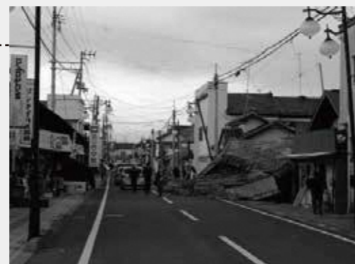
震災により倒壊した家屋
