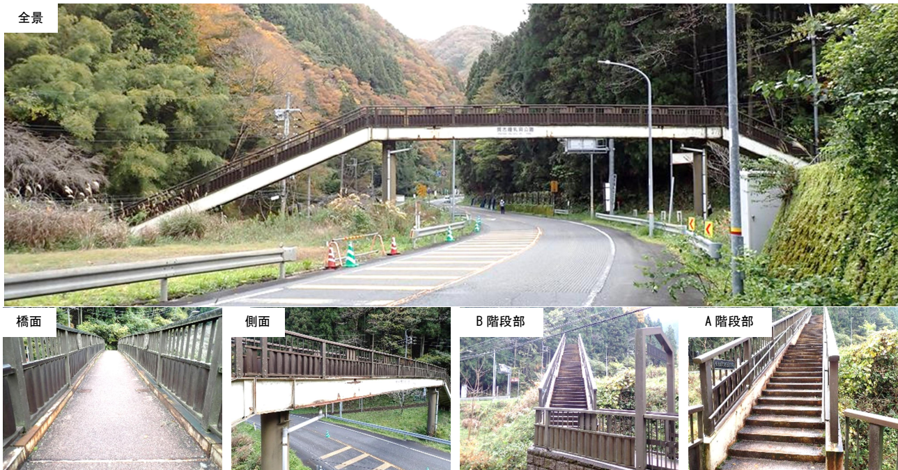
写真 1 質志鐘乳洞公園歩道橋写真
