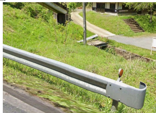
写真3 高屋川横断部(国道への通路無し)
