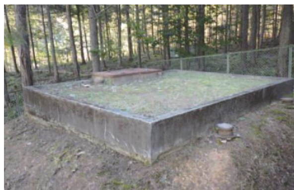
尾長野配水池
