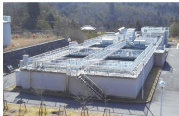
畑川浄水場(薬品沈殿池)
