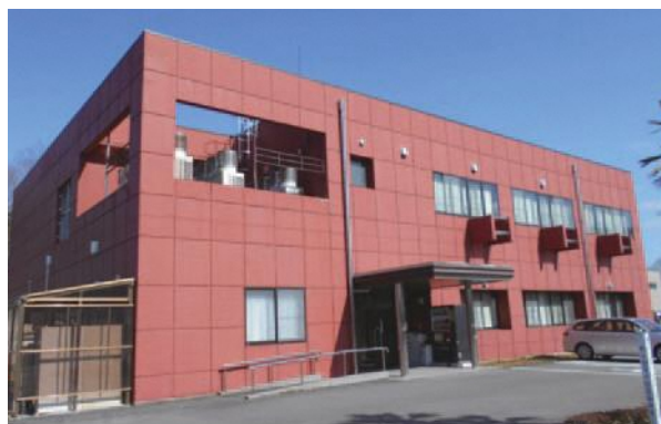
畑川浄水場(管理棟)
