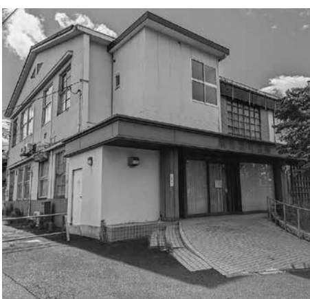
解体工事が決まった役場旧庁舎 (蒲生地内)
