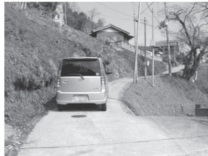
道幅の狭い町道 (町道梅田住宅線)
