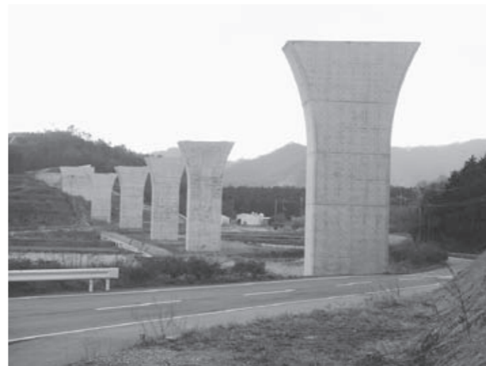
工事が進む丹波綾部道路（瑞穂地内）
