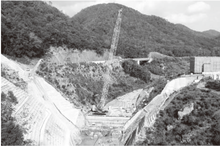
着々と建設が進む畑川ダム
