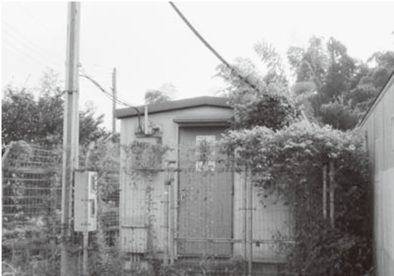
撤去される分散局（蒲生地内）
