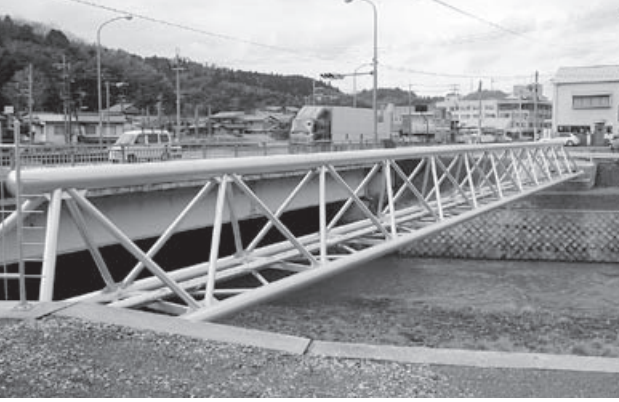
下水道管移設工事が完成（須知地内）
