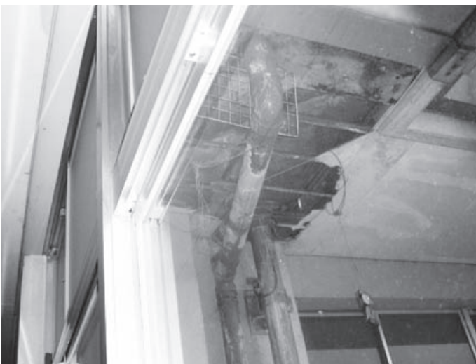
破損が著しい軒裏（蒲生野中学校）
