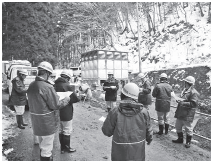
戸津川配水池築造工事の現地踏査
