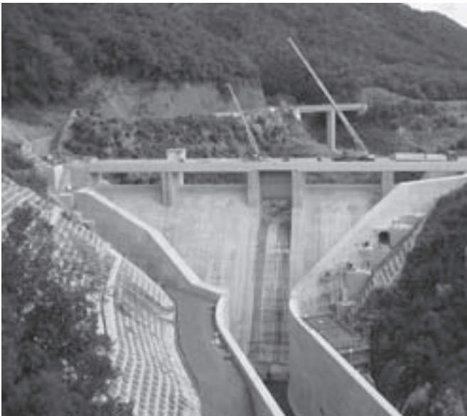
間もなく試験湛水がはじまる畑川ダム
