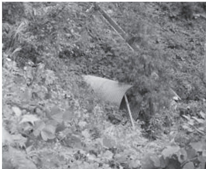
撤去されるコルゲート管（大倉地内）
