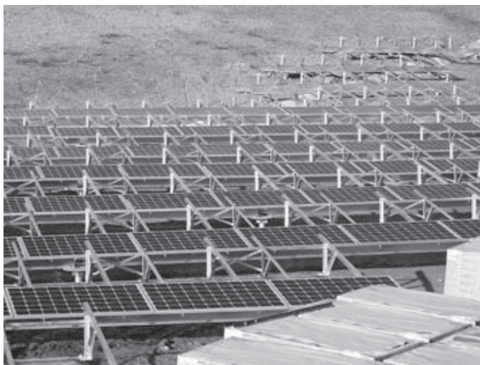
建設が進む大規模太陽光発電システム(大倉地内)
