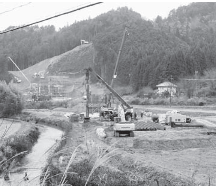
町内で施工中の縦貫道丹波綾部道路(瑞穂地内)
