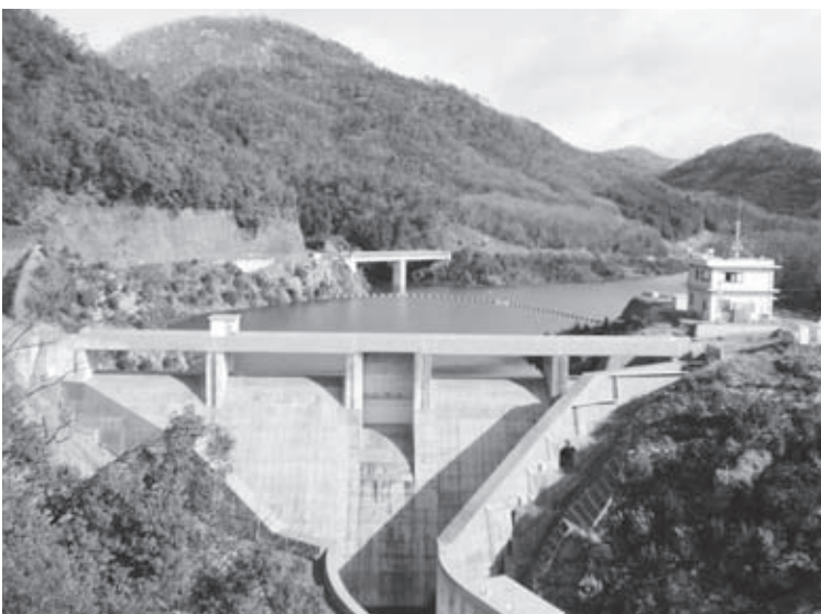
試験湛水中の畑川ダム
