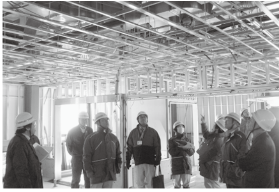
工事中の瑞穂給食センターの現地踏査
