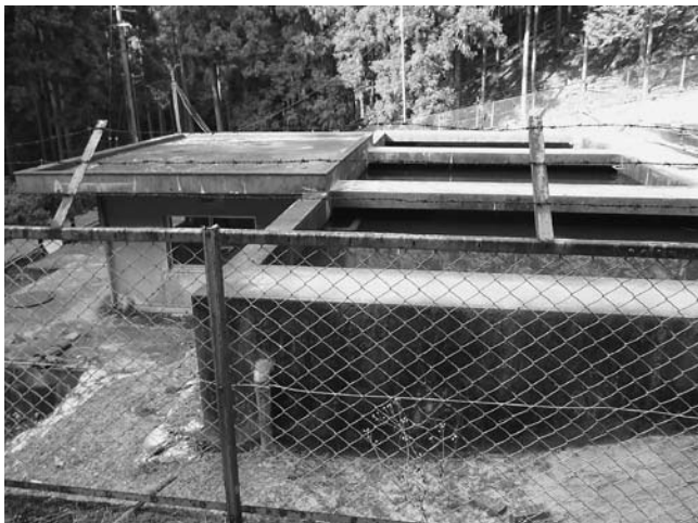
計画的に既存施設の点検を（竹野地内）
