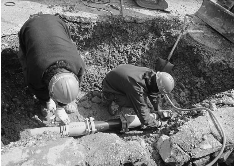
昼夜を問わず行なわれる水道管の復旧工事
