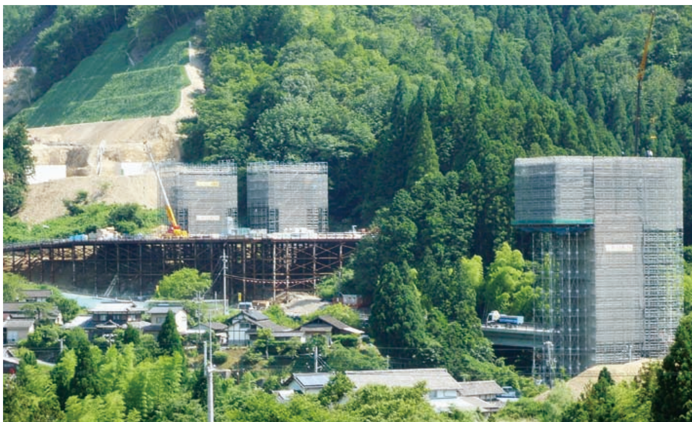
平成27年3月全線開通に向け工事が進む京都縦貫自動車道（京丹波わちインター付近）
