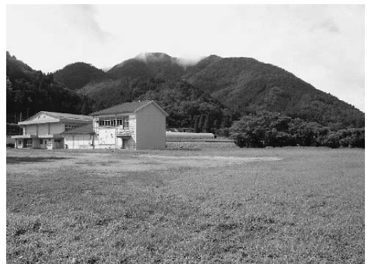
解体工事が完了した第二小学校跡地
