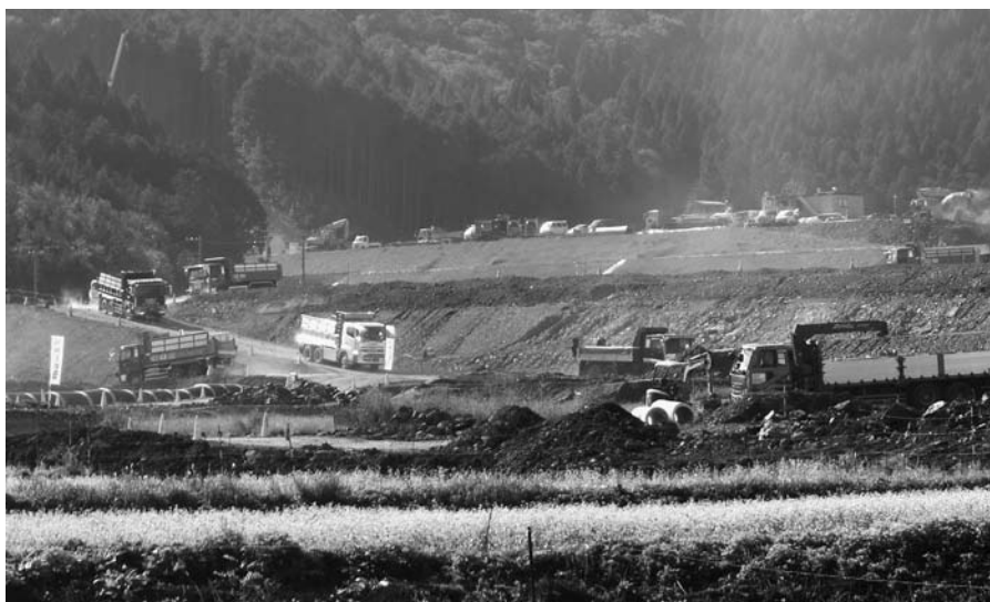
工事によるダンプラッシュ（曾根地内）
