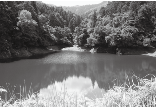
ほうしょういけ 改修工事予定の豊昌池（安栖里地内）
