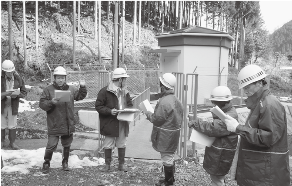
和知簡易水道 西部取水地（大簾地内）
