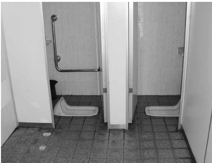
改修が待たれる狭小なトイレ（JR和知駅構内）
