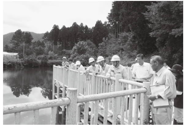
改修予定の稲荷池（坂原地内）
