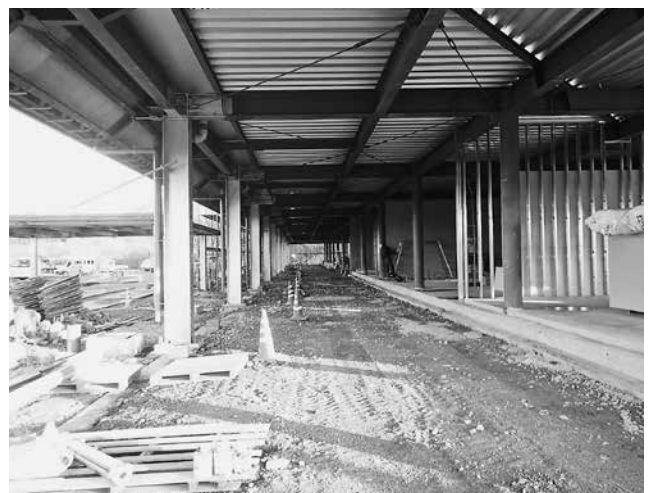
工事中の道の駅「京丹波 味夢の里」
