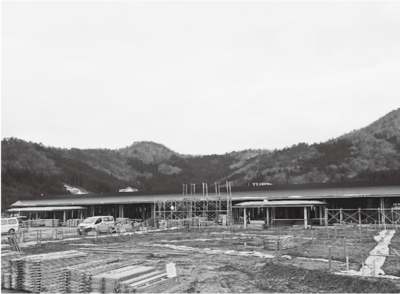
不等沈下対策が施工された道の駅「京丹波 味夢の里」
