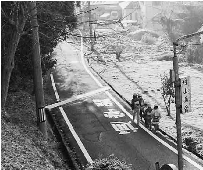
溝ぶたの設置で応急対策を(下山地内)
