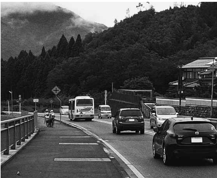
防護柵設置の要望がある下山バイパス通学路（尾長野地内）
