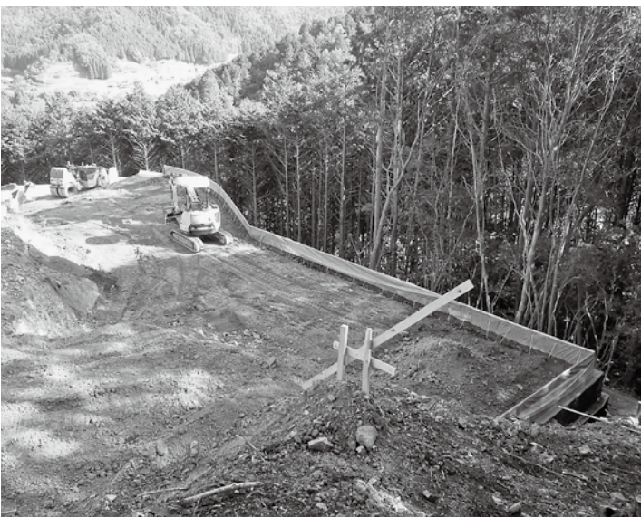
和知簡易水道事業工事現場（広野地内）
