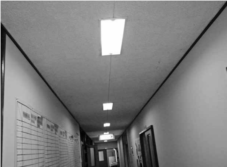
アスベスト対策の工事が完了している質美振興センター
