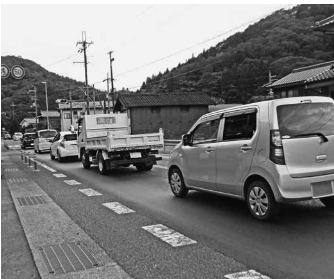
右折レーンの改良工事が待たれる国道9号(水戸地内)
