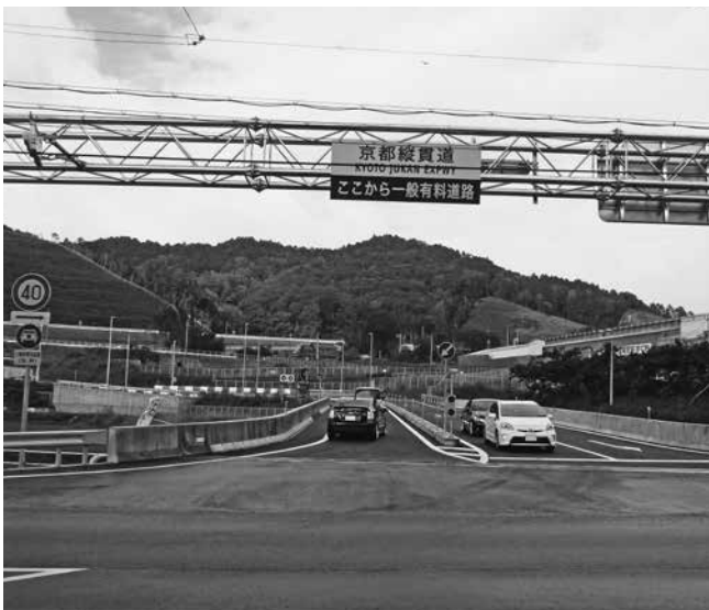
通行量の多い京都縦貫自動車道(みずほインター)
