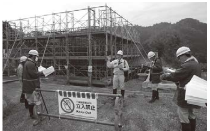
粉末炭接触槽築造工事現場(畑川浄水場)
