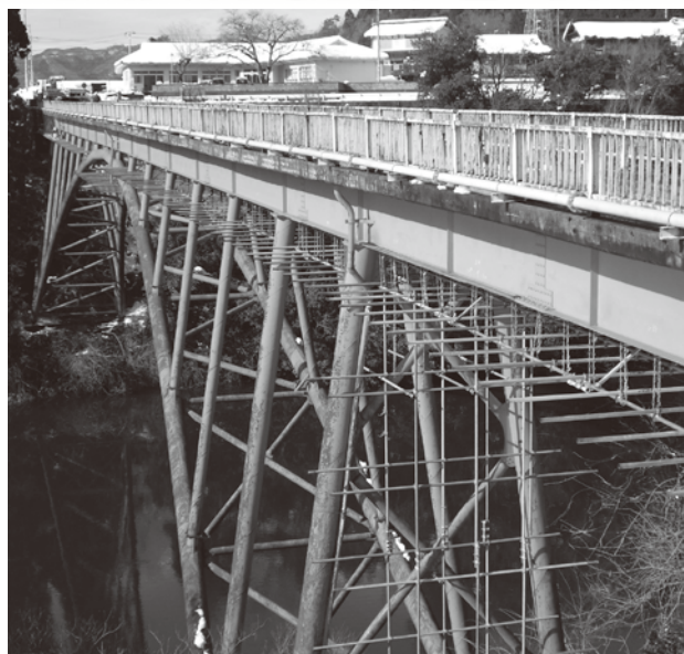
早期の完成が待たれる上升谷橋
