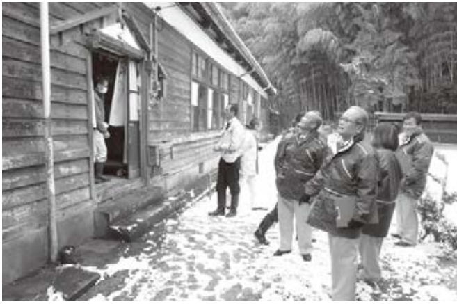
老朽化が進む旧須知小学校
