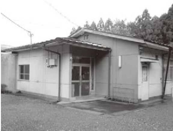
環境整備が望まれる上豊田保育所
