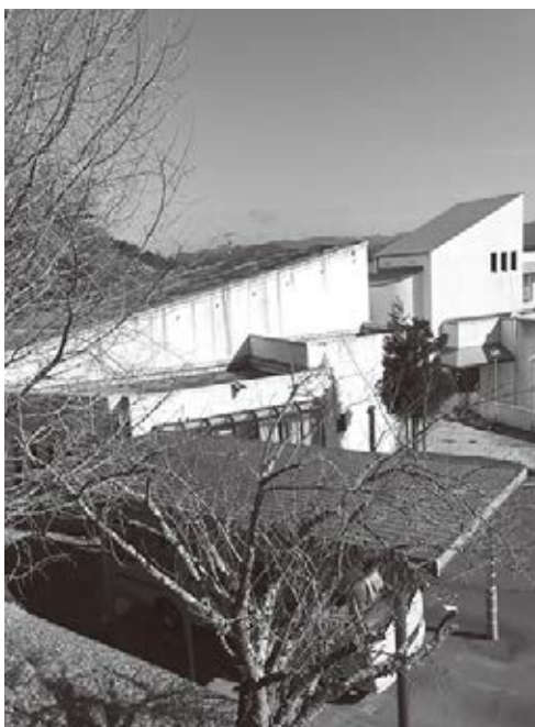
老朽化した須知幼稚園
