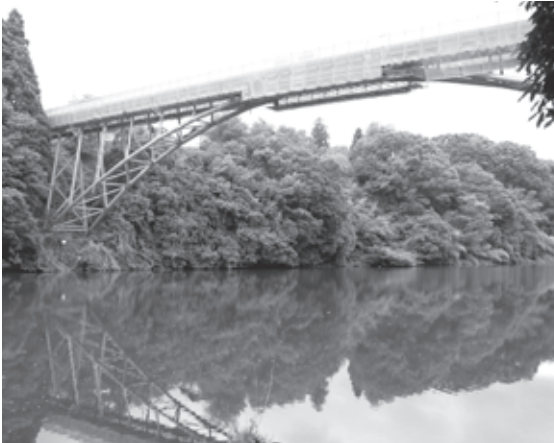
早期の完成が待たれる上升谷橋(升谷地内)
