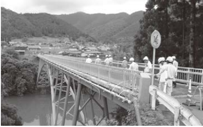
完成間近の上升谷橋橋梁補修工事
