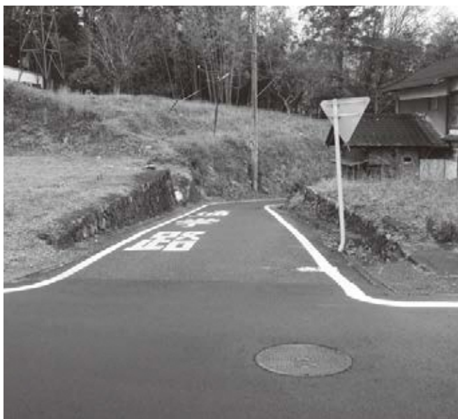
見通しの悪い急カーブ(下山地内)
