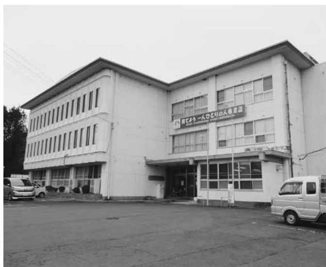
一日も早い耐震調査が望まれる中央公民館（蒲生地内）
