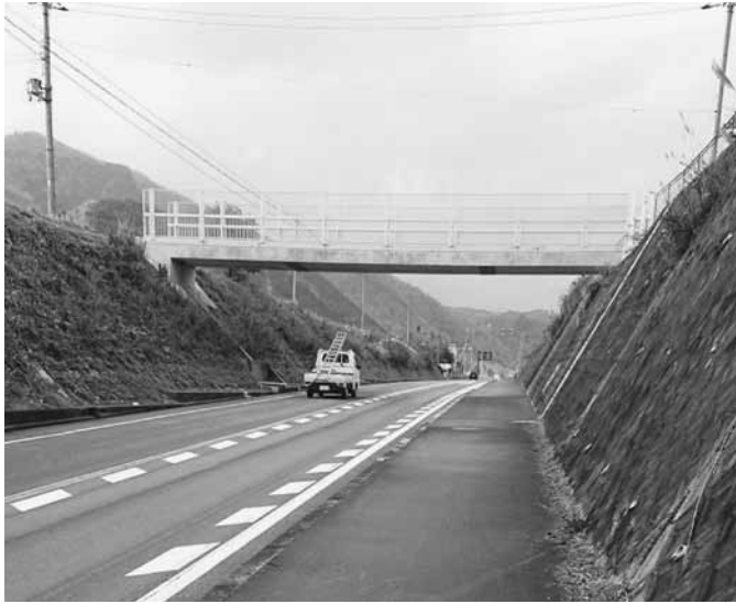
完成した白土跨道橋（白土地内）
