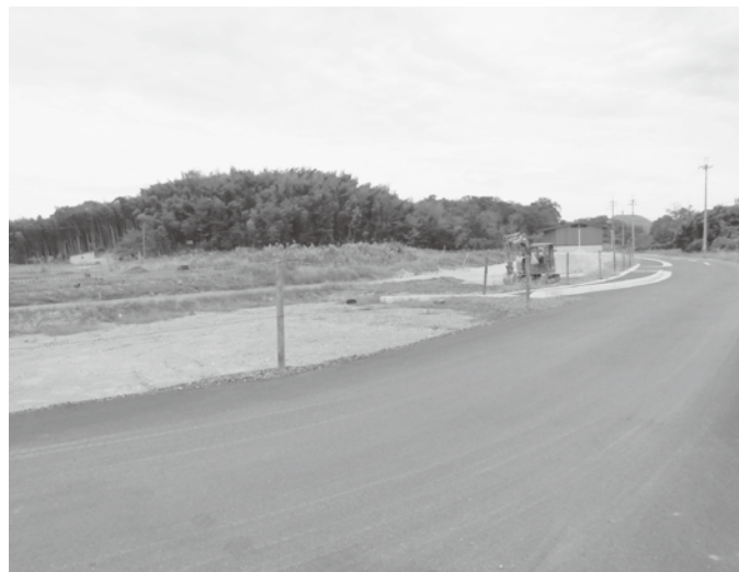
道路整備が進む新庁舎建設予定地付近 (蒲生野地内)
