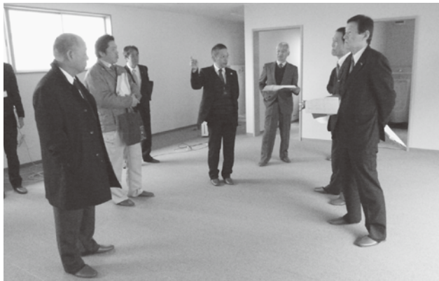
のびのび児童クラブ1組施設建設現場 (丹波ひかり小学校内)
