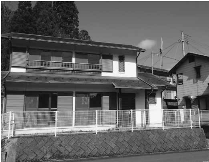
長期空き家となっている町営住宅
