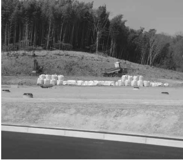
いよいよ新庁舎本体工事着工
