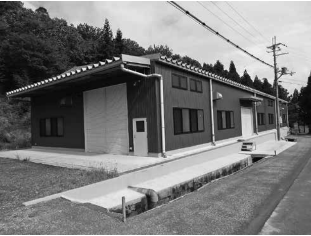
ロケーション施設(安井地内)
