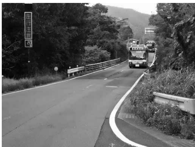
工事着手が決まった白土橋（下山白土地内）
