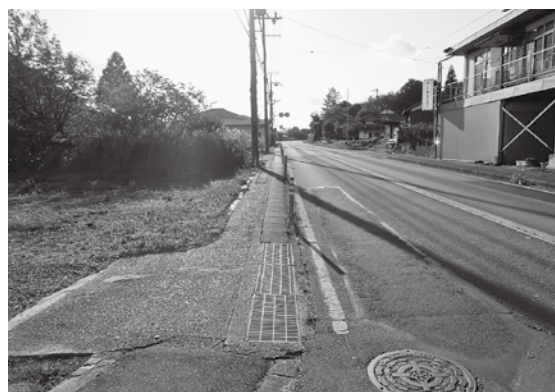
拡幅予定の歩道(橋爪地内)
