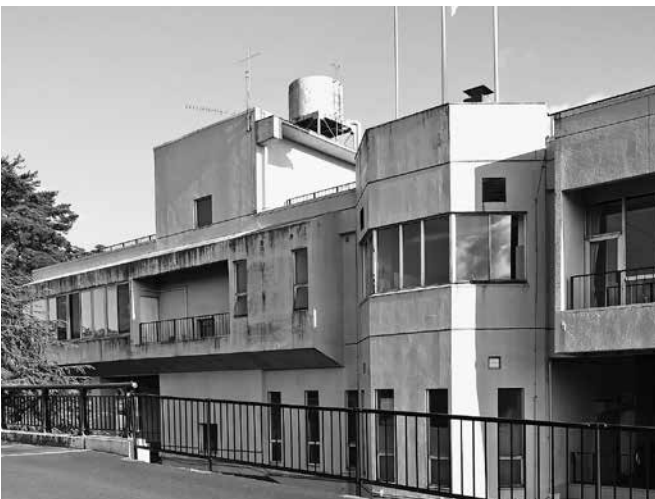
丹波自然運動公園管理棟
