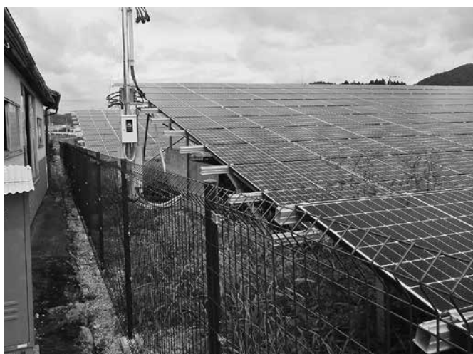
いまだに連絡先の看板が設置されない施設（和田地内）
