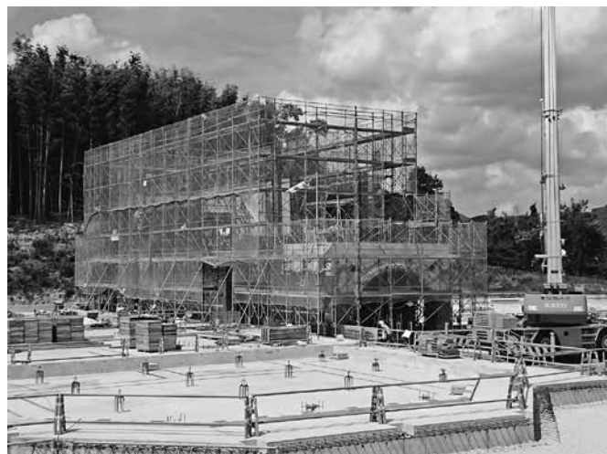
新庁舎建設工事現場
