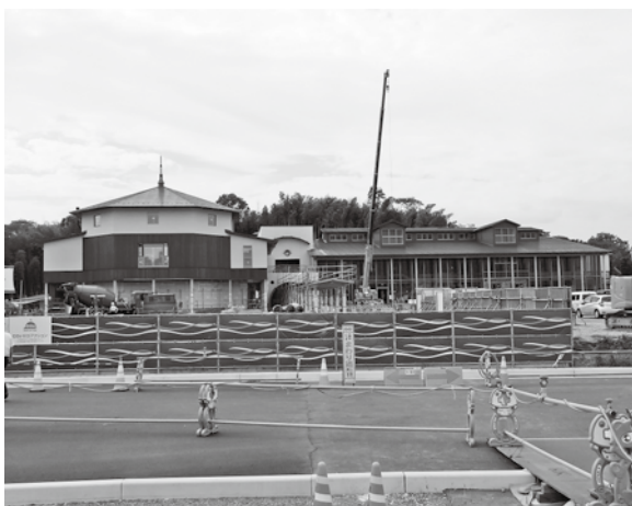
着々と建設が進む新庁舎
