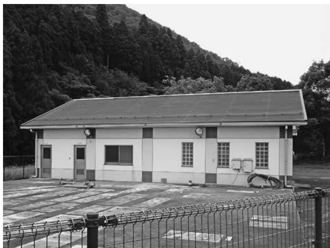
住民の生活に欠かせない下水道(処理施設)
