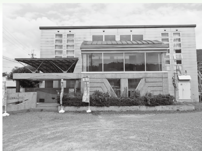
(株)ZTVに無償譲渡する丹波サブセンター
