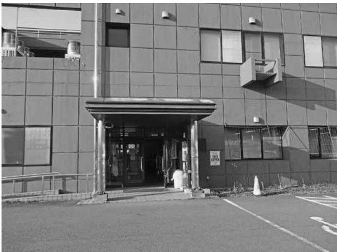
上下水道課(水道事業畑川浄水場)
