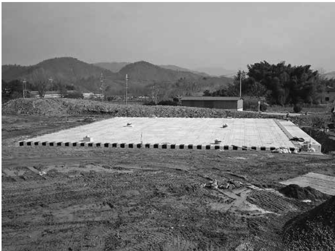
役場駐車場埋設前の雨水地下貯留槽
