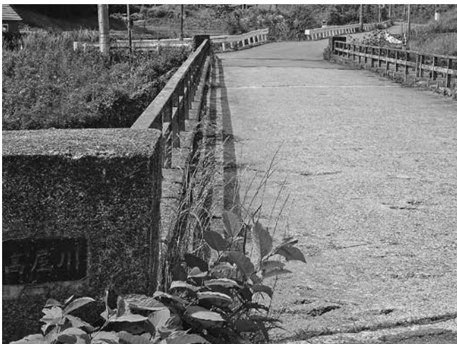
巡見橋から町道豊田曾谷線
