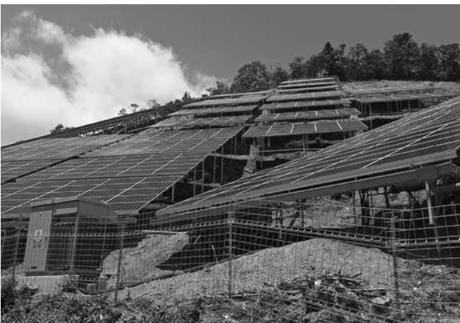
建設の進む太陽光発電施設(井尻地内)
