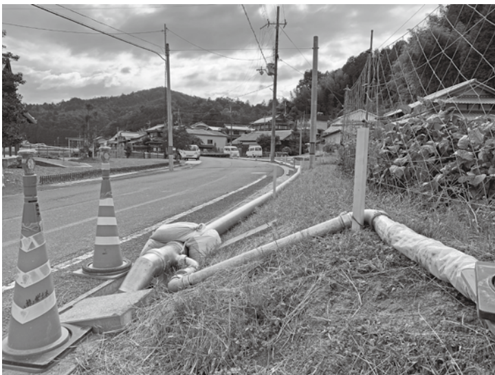
上水道管更新工事(口八田地内)
