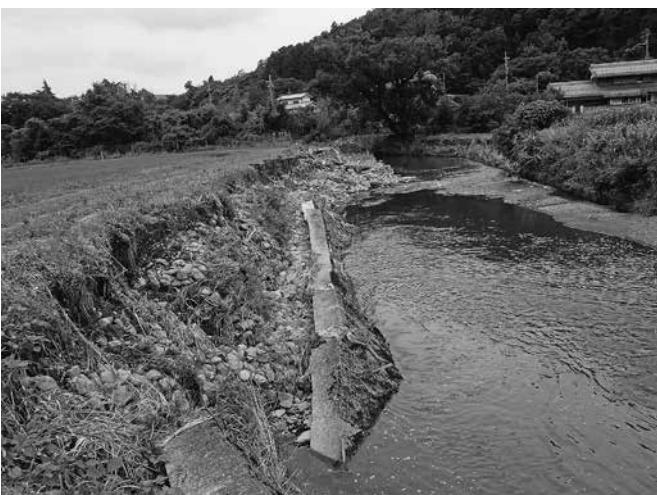
豪雨で被災した高屋川(橋爪地内)
