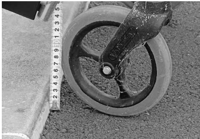
本庁舎駐車場と列柱廊の段差(一部)
