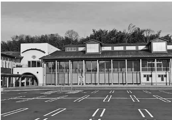
庁舎・駐車場
