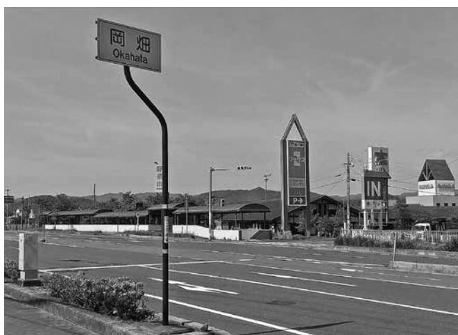
国道9号 岡畑交差点(須知地内)
