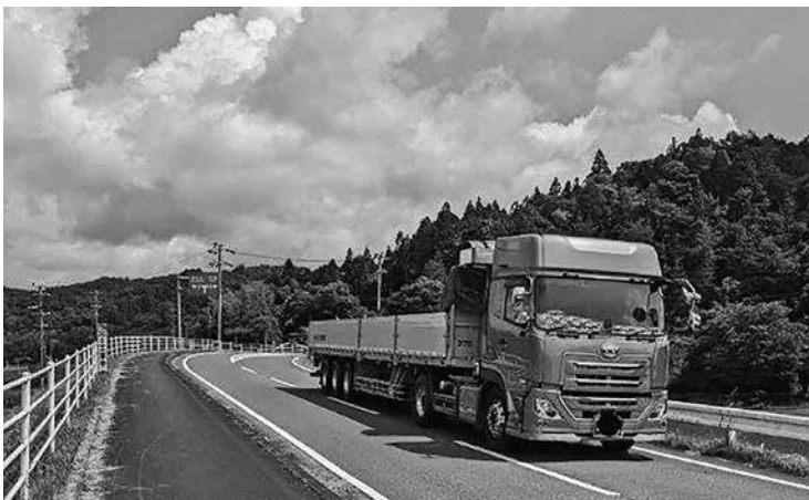
大型車両が行き交う町道八田井尻線(井尻地内)
