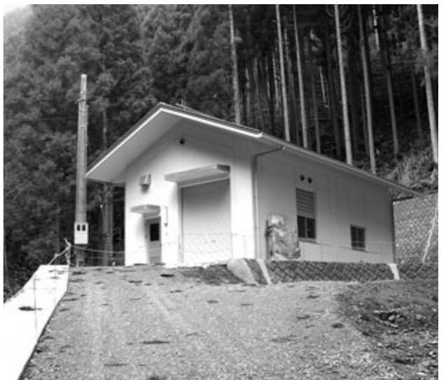
改良された水道施設（仏主）
