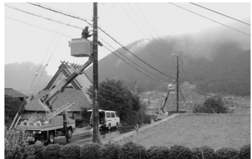
順調に進む光ケーブル敷設工事(本庄地内)
