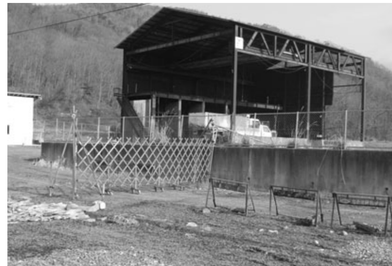
産業廃棄物中間処理施設の建設予定地(下山地内)
