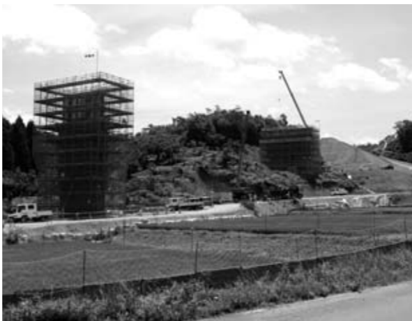
工事が進む京都縦貫道(大朴地内)
