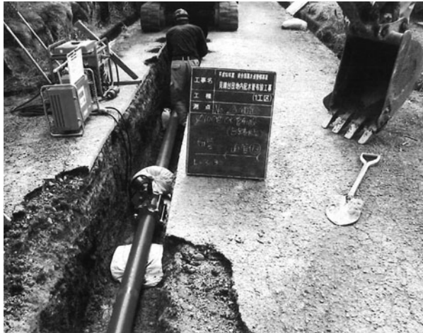
開発団地内の水道管布設工事
