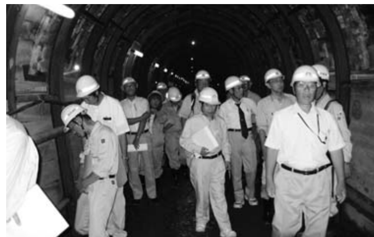
沢水処理のトンネル水路(煙川ダム)
