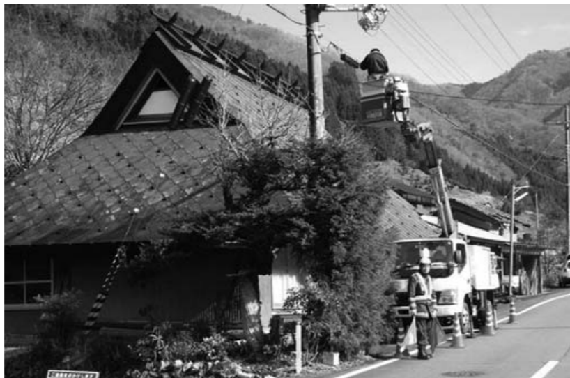
引き込み線工事が始まったケーブルテレビ（上乙見地内）
