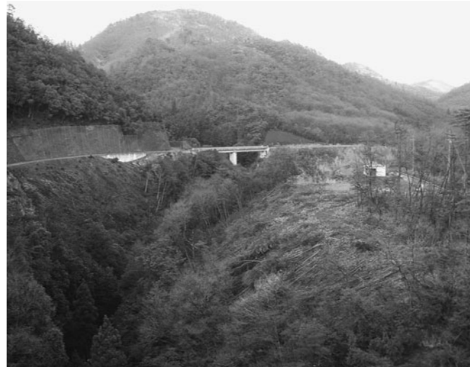
畑川ダム建設工事現場(27号バイパスより)
