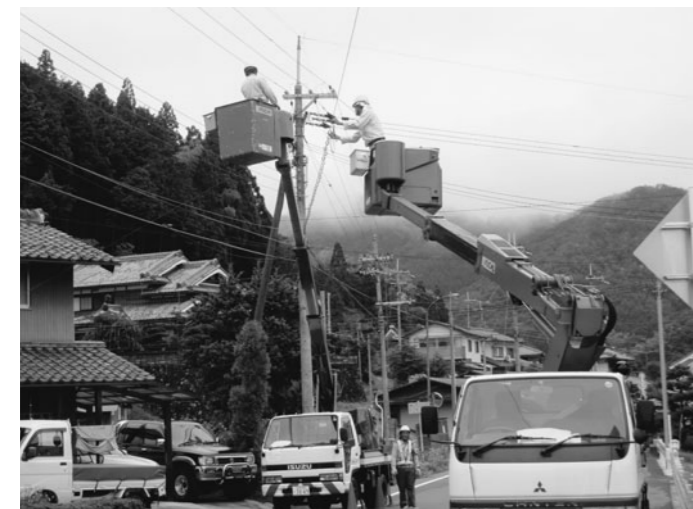
工事が進むケーブルテレビ(丹波地区)
