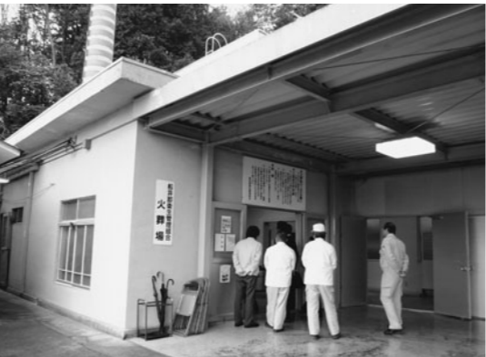
船井郡衛生管理組合火葬場
