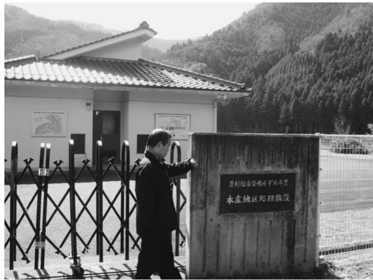
農業集落排水施設(本庄地内)
