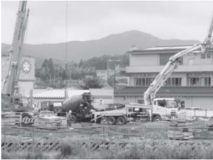
基礎工事が進む保育所新築現場(和田地内)
