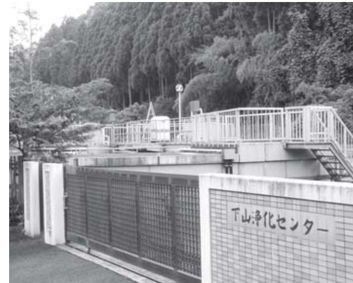
処理人口2600人(下山浄化センター)
