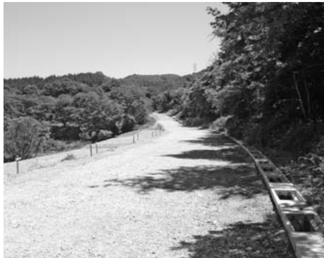
工事途中で全面開通が待たれる町道235号線
