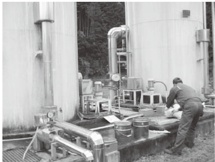
水道施設の点検作業(水原浄水場)
