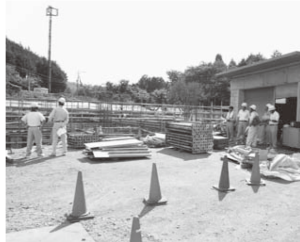
統合小学校増改築工事現場
