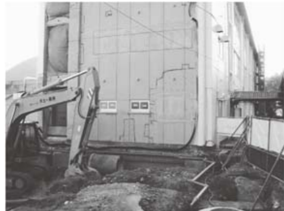
松山小学校エレベーター工事
