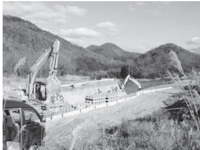
ダム周辺整備候補地と町道235号線工事現場
