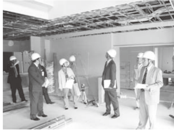
みずほ保育所工事現場
