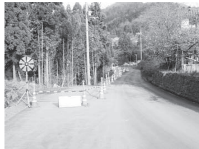
2月完成予定の町道改良工事（升谷地内）
