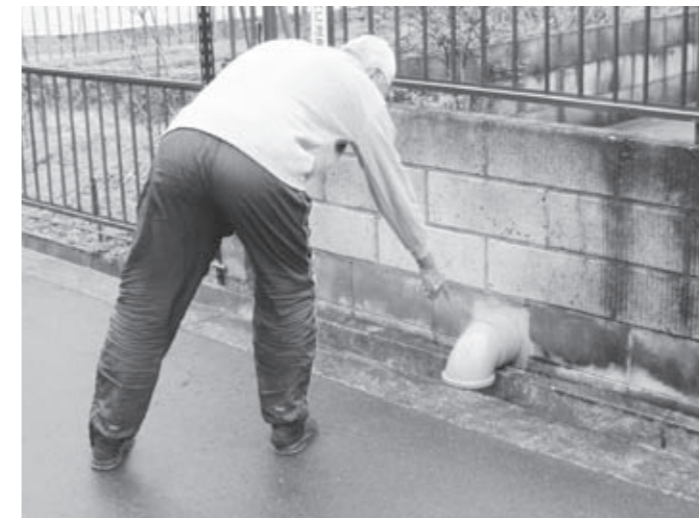
汚水の緊急排出のため取り付けられた塩ビ管（グリーンハイツ区）
