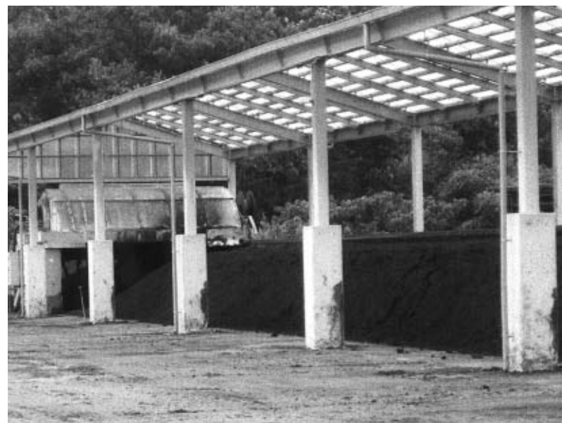
北部堆肥センター発酵処理施設(上新田)
