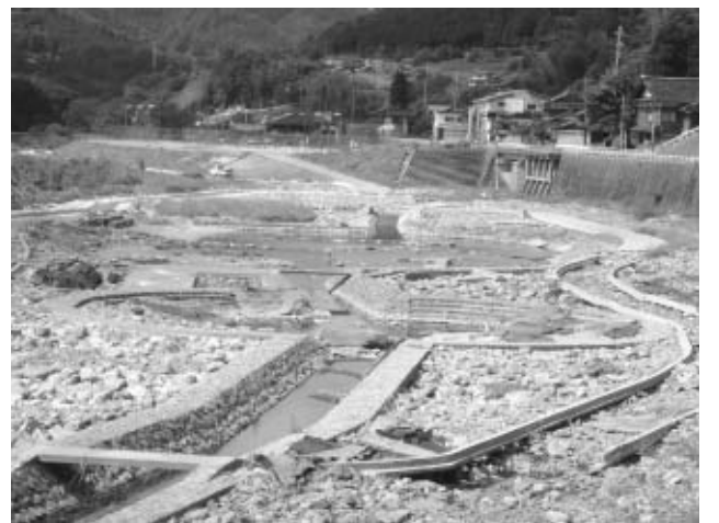
水害に見舞われた親水公園(坂原地内)
