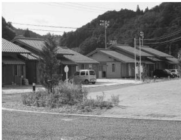
町営住宅4戸が建設される三ノ宮団地
