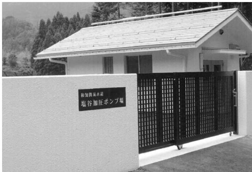
汚職事件につながった塩谷加圧ポンプ場
