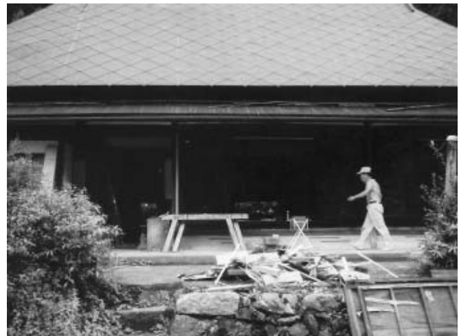
改装中の空家(上乙見)
