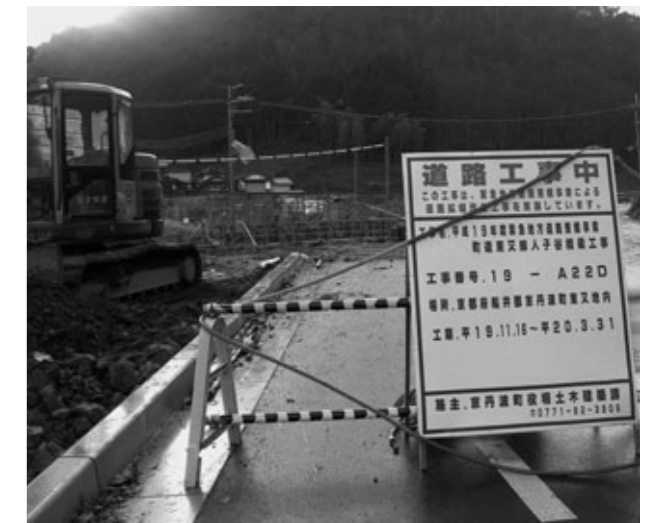
人子谷橋梁工事（東又地内）
