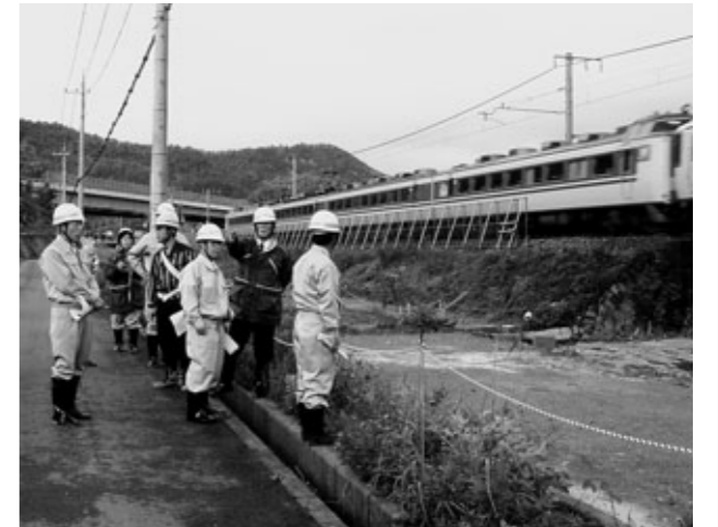
工事が進む山陰本線複線化事業(南丹市八木町内)
