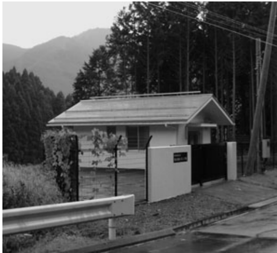
汚職事件につながった塩谷加圧ポンプ場
