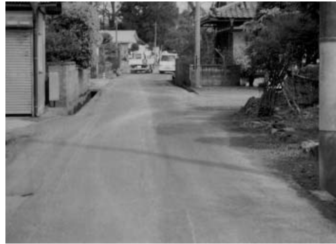
すれ違いが困難な町道（院内地内）
