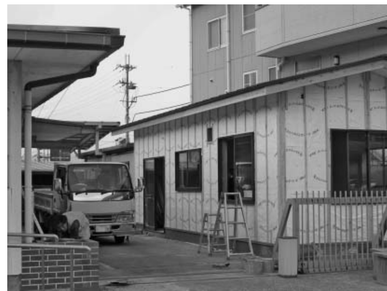
建設中の給食室（丹波共同作業所）
