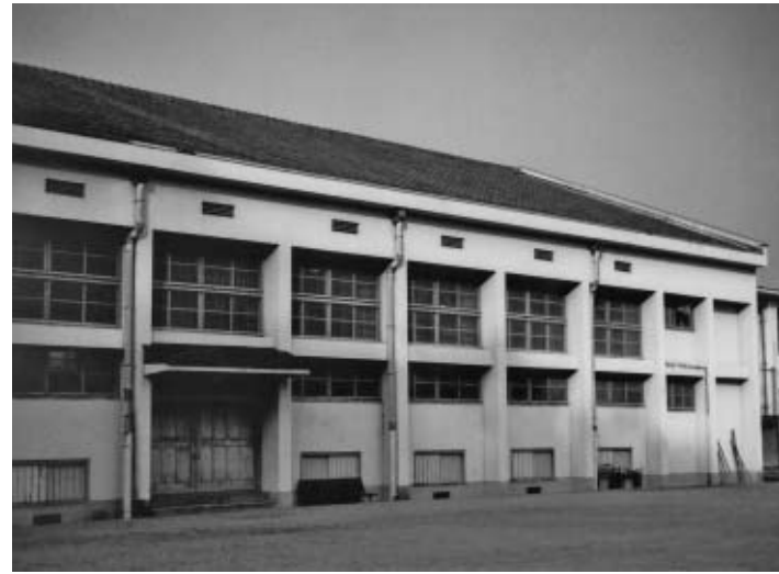
一日も早い改修を (瑞穂中体育館)
