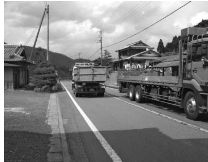
改良が急がれる国道27号（中山地内）
