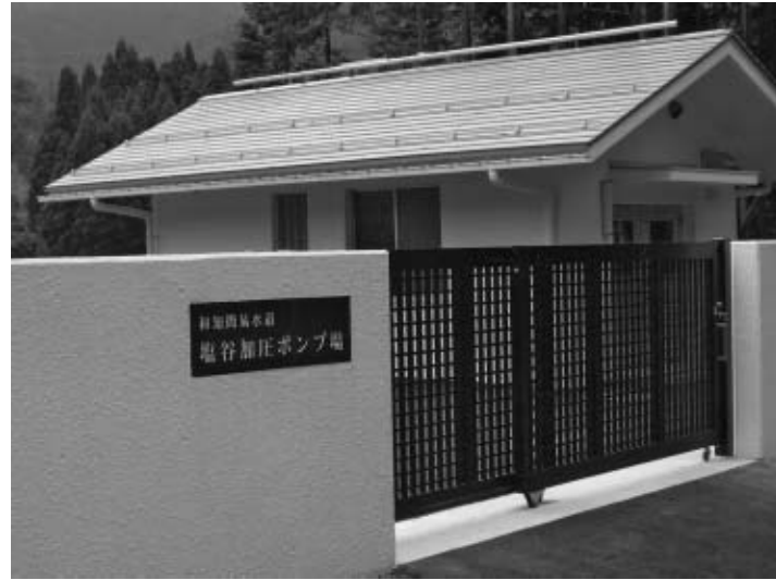
汚職の舞台となった水道施設（塩谷地内）
