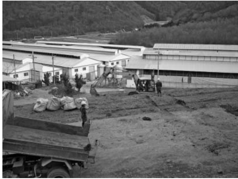
すべて処分される旧浅田農産の埋却跡
