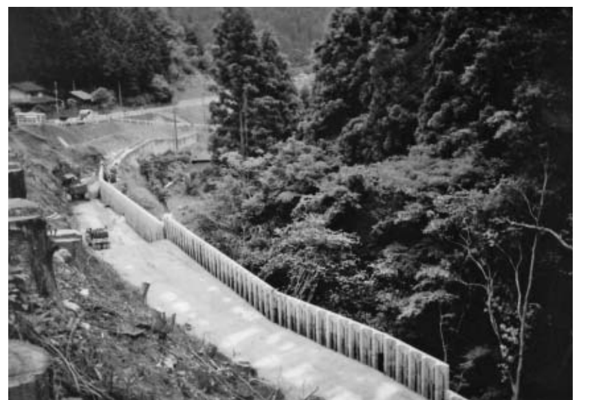
完成が待たれる町道（下乙見地内）
