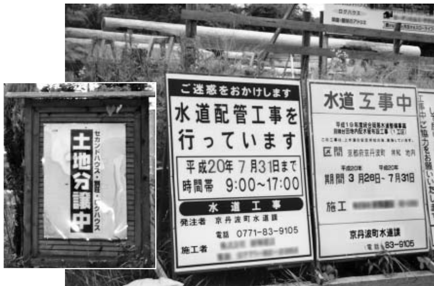
本管工事が進む分譲地（井尻地内）
