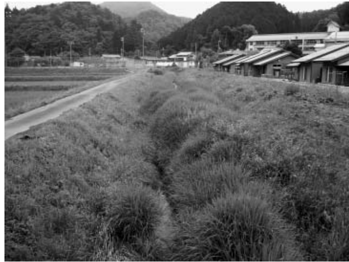
土砂が堆積した高屋川（三ノ宮地内）
