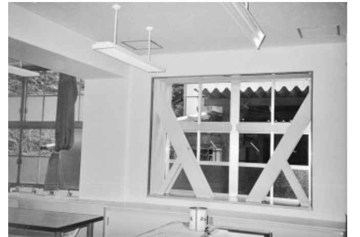
耐震工事が進む小学校 (下山小学校)
