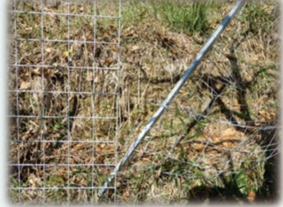
写真：熊になぎ倒されたフェンス
