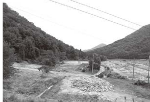
建物の撤去工事が進む旧浅田農産跡地
